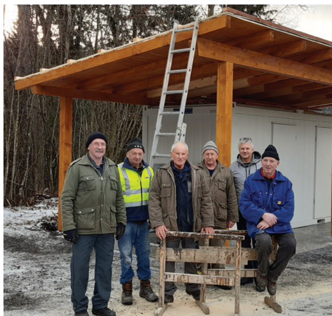
Bauarbeiten zur Errichtung einer WC-Anlage gegenüber dem Friedhof in Kranichberg. Allen, die mitgeholfen haben, sei herzlichst gedankt.
